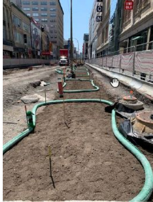
Préparation fosses d'arbres (aération)
