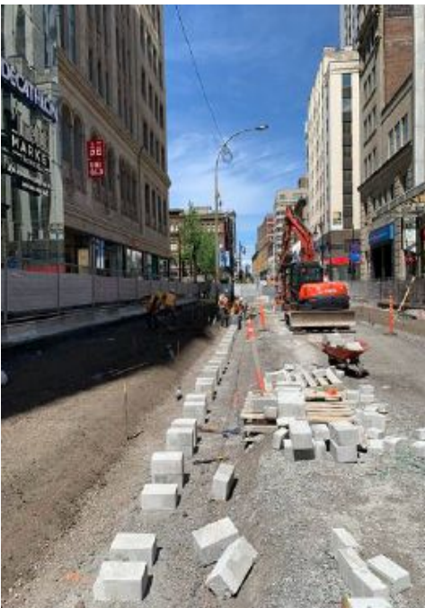
Préparation pour pose de bordure
