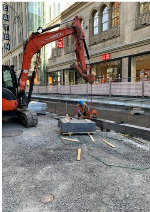
Mise en place des bordures de granite
