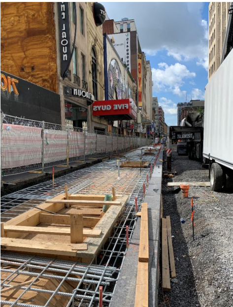
Préparation pour bétonnage dalle
