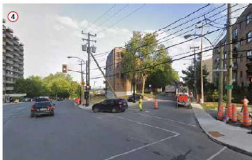
4 CHEMIN DE LA CÔTE-SAINT-LUC COIN AVENUE BONAVISTA (vue vers le nord-ouest)
