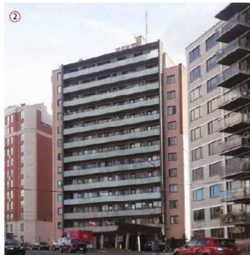
2 THE BOULEVARD 4840 CHEMIN DE LA CÔTE-SAINT-LUC (vue vers l'est)
