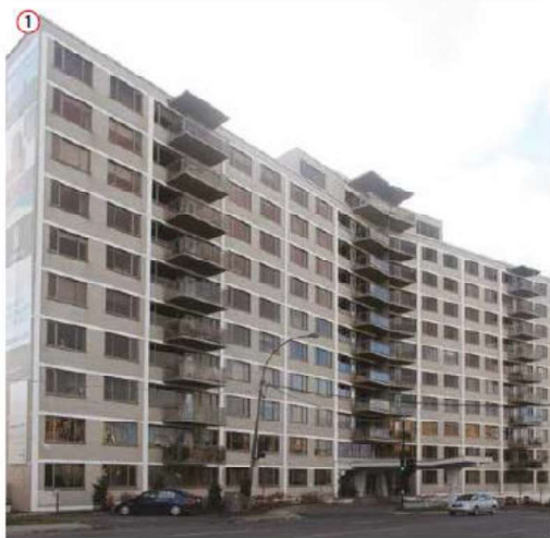
1 LE MONTEBELLO 4850 CHEMIN DE LA CÔTE-SAINT-LUC (vue vers le sud)
